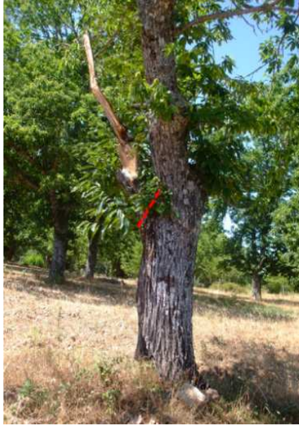
Figura 5 - Castanheiro onde ocorreu um esgaçamento de um ramo (a tracejado o local onde se deve efetuar o corte)
